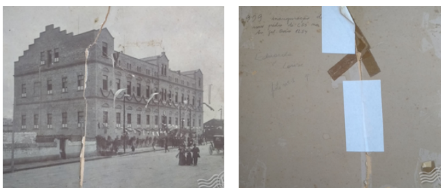
Fotos da construção e convite de inauguração da escola Espírito Santo em Bagé
