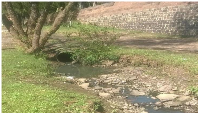
Figura 6. Esgoto liberando pequenas quantidades de efluentes no rio no P1
