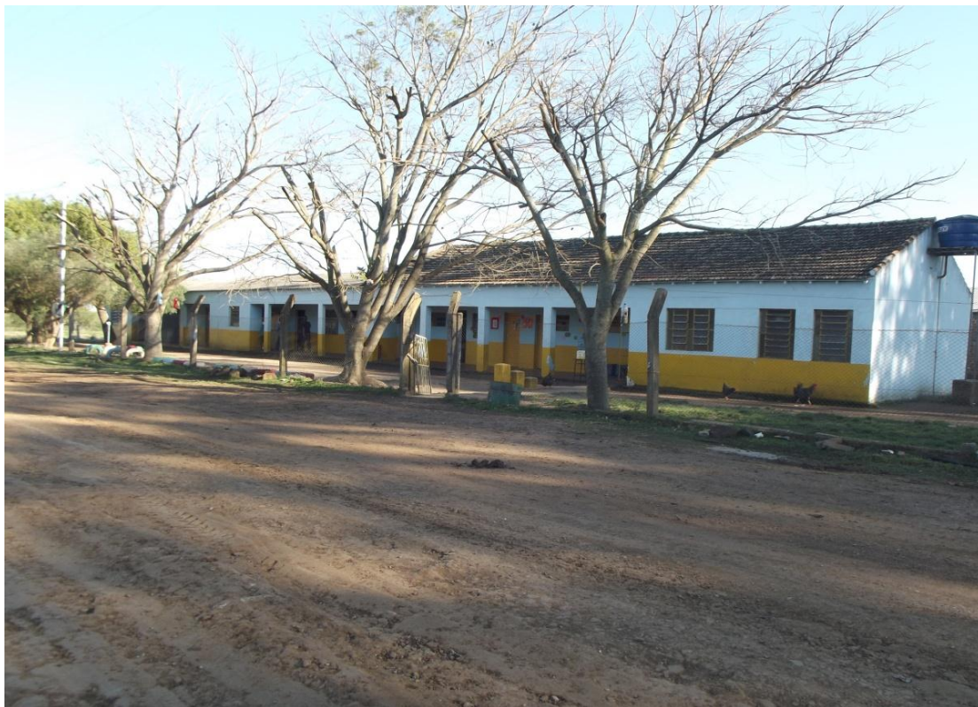
Figura 3: Fachada da escola
