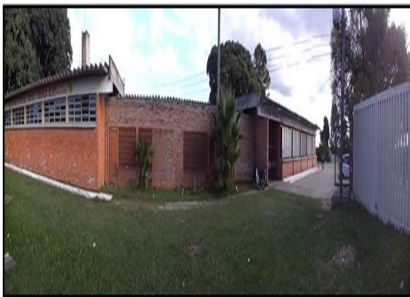
Imagem 1: Fachada das escolas
