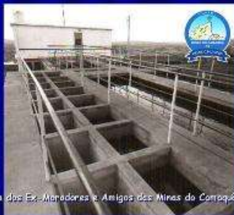
Tratamento de Água – Tanques de Decantação da Hidráulica
