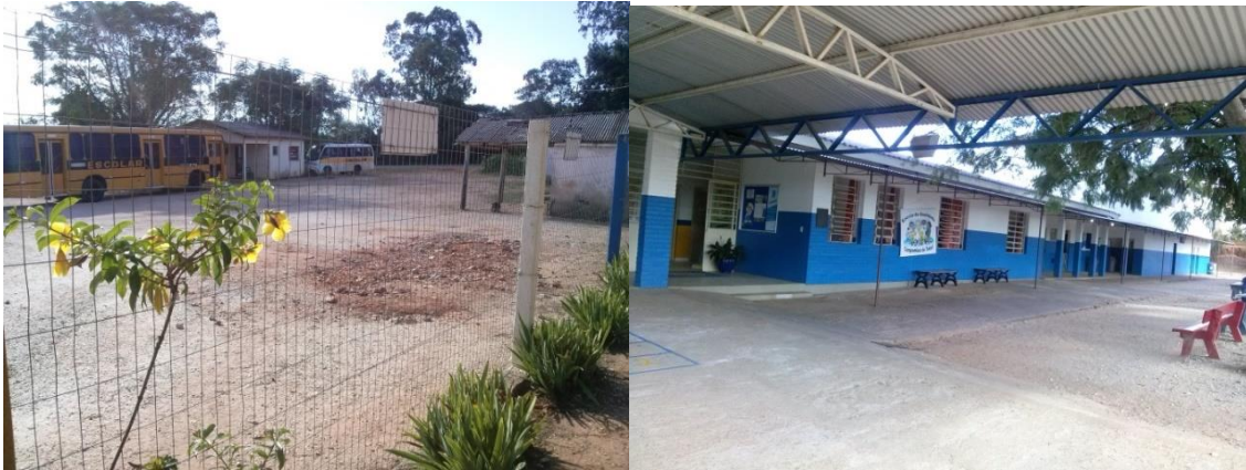
Figura 1 (À esquerda) – Área de estacionamento do transporte escolar. (Fonte: Acervo do autor)
