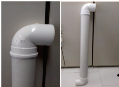
Figura 5 - Colocação de joelhos e conexões
