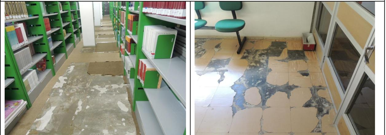
**PRÉDIO ADMINISTRATIVO:** Necessita de reforma arquitetônica, o prédio possui piso com diversas rachaduras e buracos e teto com infiltrações.
