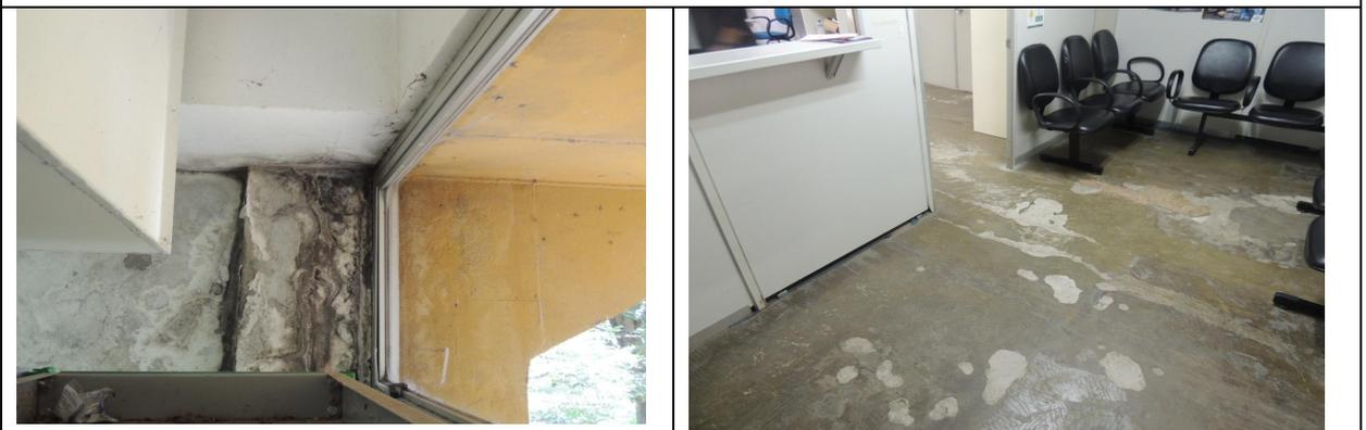
**PRÉDIO 100:** Necessita de reforma arquitetônica, prédio com infiltrações e tetos e paredes rachadas.
