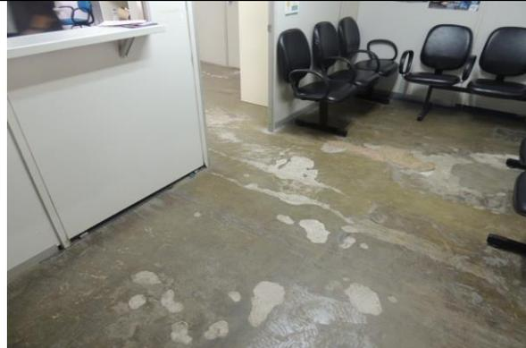
**PRÉDIO 100:** Necessita de reforma arquitetônica, prédio com infiltrações e salas com tetos e paredes rachadas.
