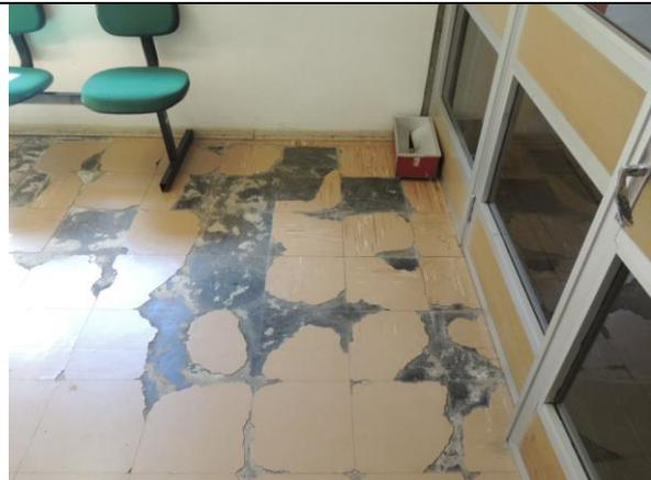
**PRÉDIO ADMINISTRATIVO:** Necessita de reforma arquitetônica, o prédio possui piso com diversas rachaduras e buracos e teto com infiltrações.
